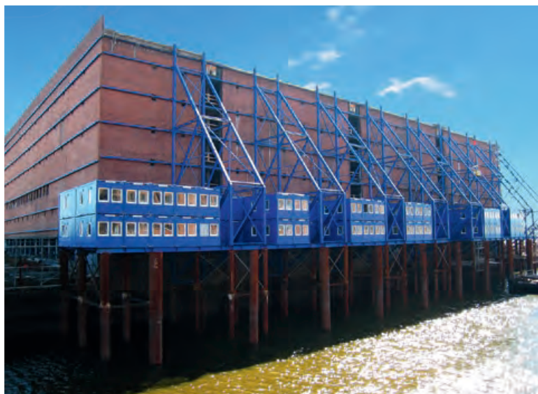
Bureau de chantier en milieu difficile
