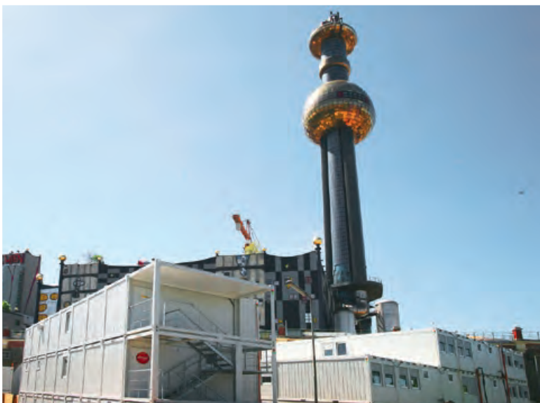
Bureau de chantier
