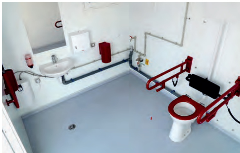
Vue intérieure accès PMR selon norme DIN 18040-1
