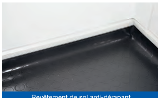
Revêtement de sol anti-dérapant (remonté sur les bords)
