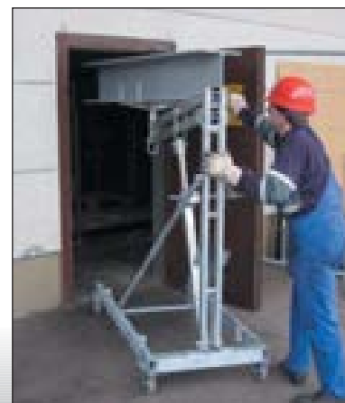
Insertion d'une poutre en acier au moyen de deux élévateurs à bras en porte-à-faux. La manivelle permet d'amener la poutre en acier à la hauteur souhaitée.
