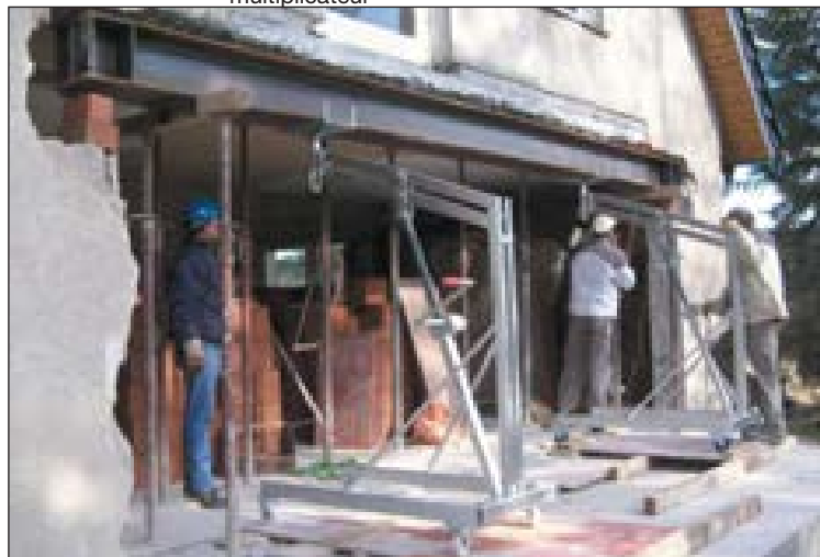
Insertion d'une poutre en acier au moyen de deux élévateurs à bras en porte-à-faux. La manivelle permet d'amener la poutre en acier à la hauteur souhaitée.
